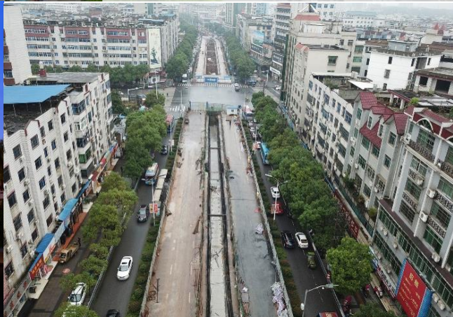
Gongyuanlu Box Culvert
